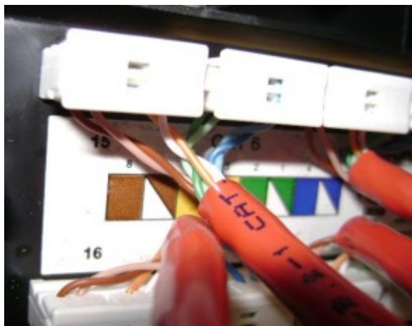
Exemplo de boa execução de conectorização.
