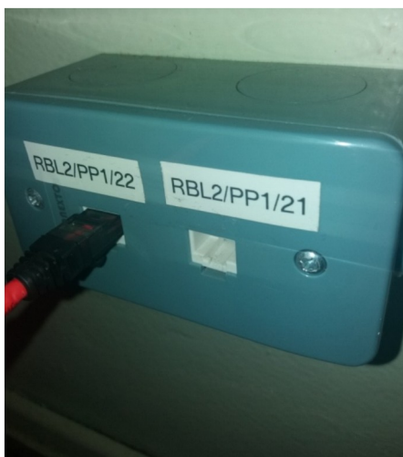
Fig. 7: Ponto de rede x2 devidamente identificado.
