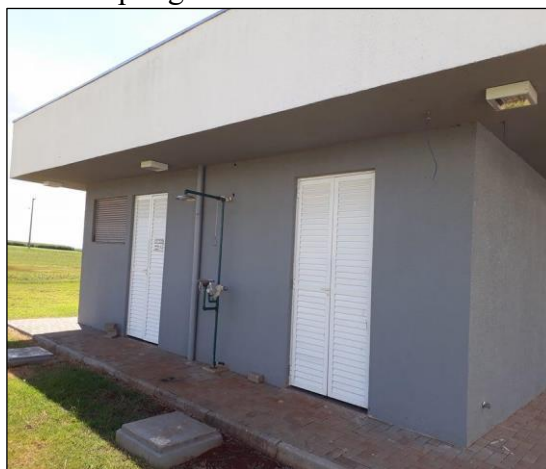
Fotografia 18 – Vista externa do abrigo de resíduos perigosos.
