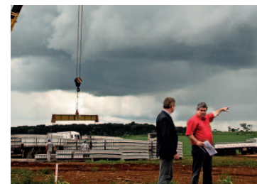
Junho/2010 - Obras em andamento no Campus Chapecó.
