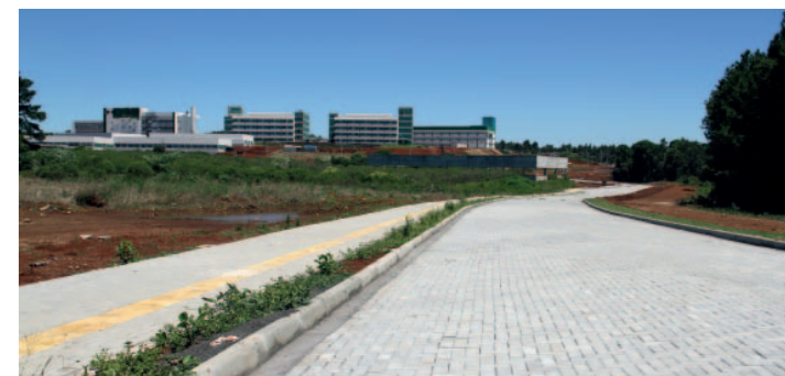
Maió/2015 – Abertura do acesso pavimentado ao campus.
